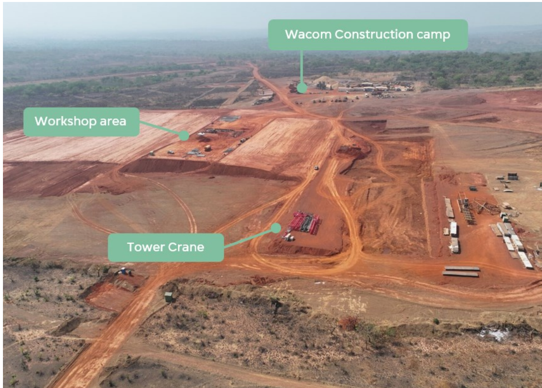
Kiniero construction site
