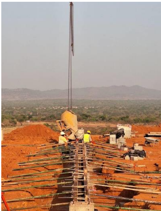
Illustration 2 – Coulée des fondations de l’atelier de production à Kiniero
