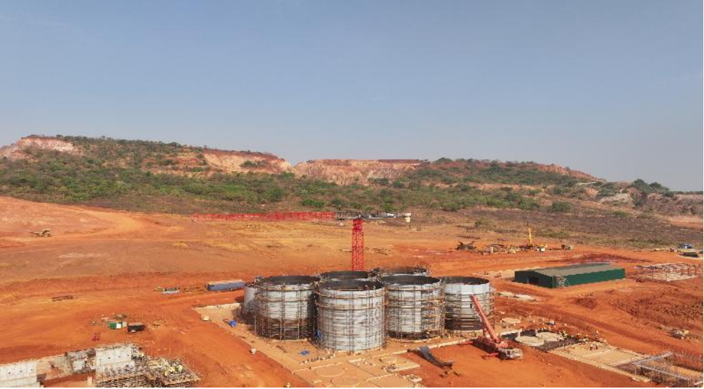
1. Kiniero CIL tank erection
